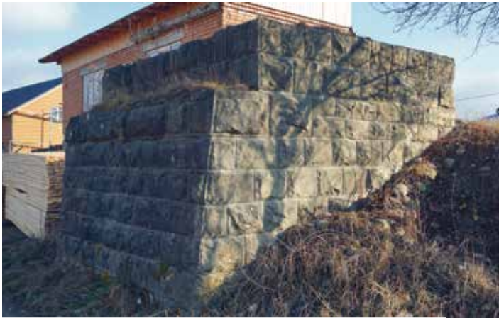
Zachowane, kamienne przyczółki przedwojennego mostu na rzece Czeremosz
