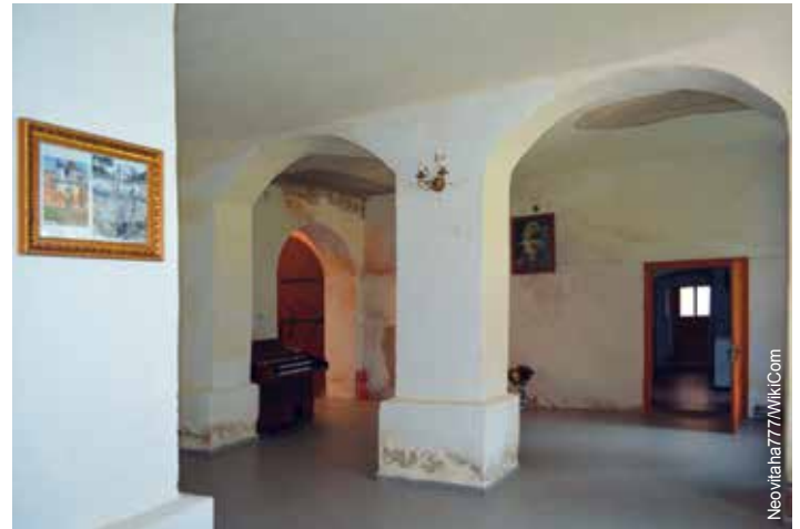
We wnętrzu klasztoru trwają prace remontowe, w świątyni rekonstruuje się dawne wyposażenie / У внутрішніх приміщеннях монастиря тривають ремонтні роботи, у храмі реконструюється старе обладнання
