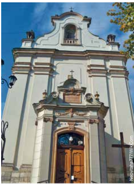
Elewacja kościoła św. Antoniego z Padwy we Lwowie
